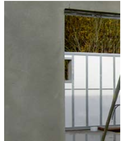
Utsida av betong och insida av stålreglar och cellplast – en överträffad kombination!
